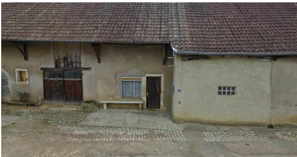
Vue partielle des deux constructions pouvant accueillir des logements supplémentaires.
