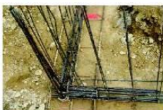
Nœud de chaînage - Continuité mécanique
