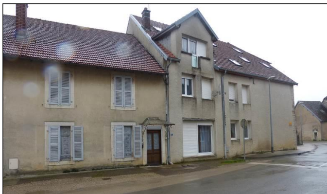
Porte de grange remplacée par une porte fenêtre
