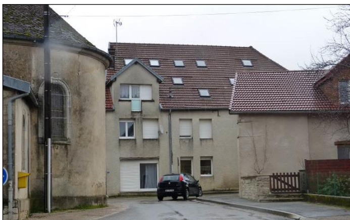
Equilibre des ouvertures en toiture à revoir
