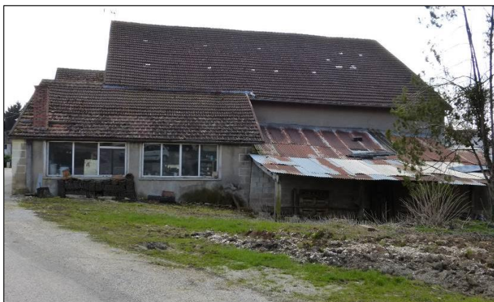
Annexe avec un toit en tôle.
